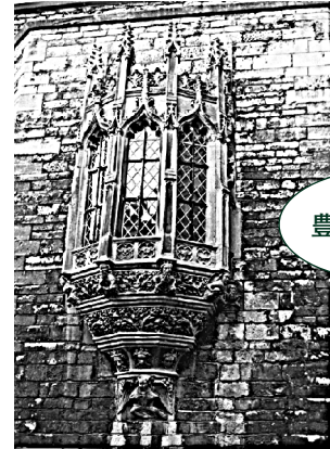
108. 持送りに彫刻の施されたオリエル窓。Lincoln Castle (リンカン城)。Lincolnshire [E]
